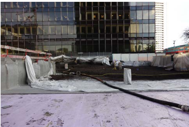
Travaux de remblais en billes d'argile.
