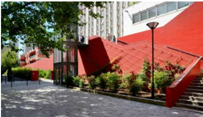
PROJET ET RÉALISATION : 2014 - 2011
