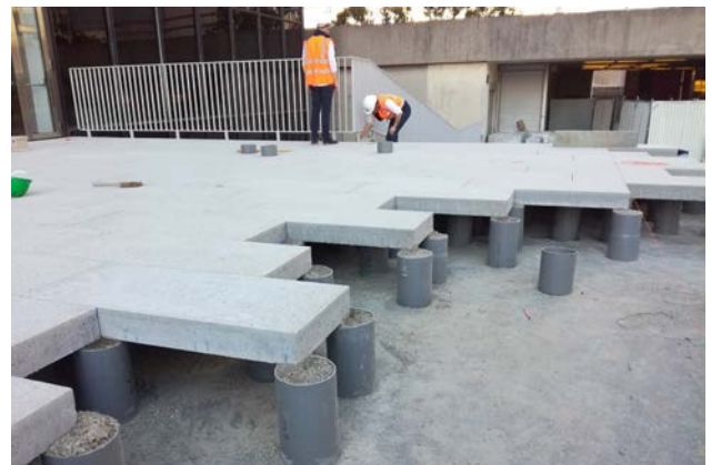
Surface sans pente, au niveau des seuils d'entrée, réalisée sur plots.
