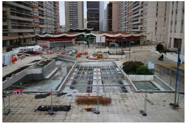
Le Parvis pendant les travaux
