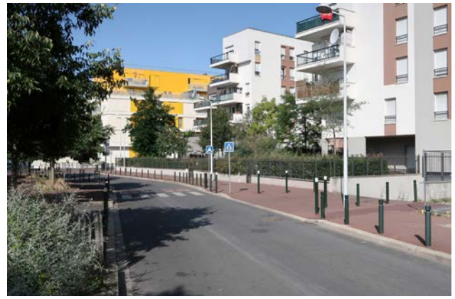
Voie créée et arrière des îlots donnant sur l'avenue. 2019
