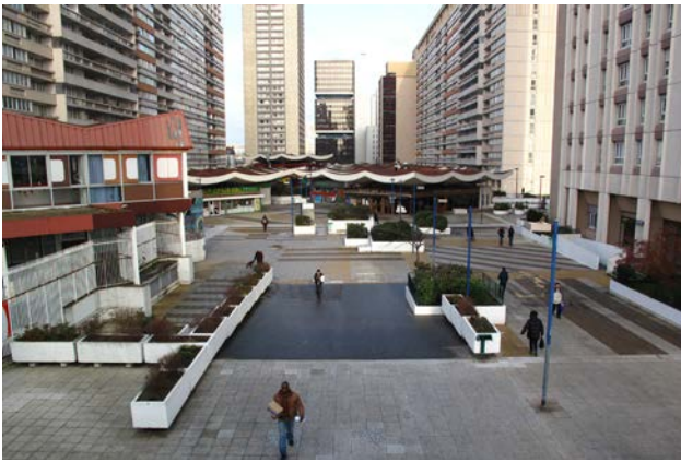
Le Parvis avec, à gauche, la crèche qui sera démolie
