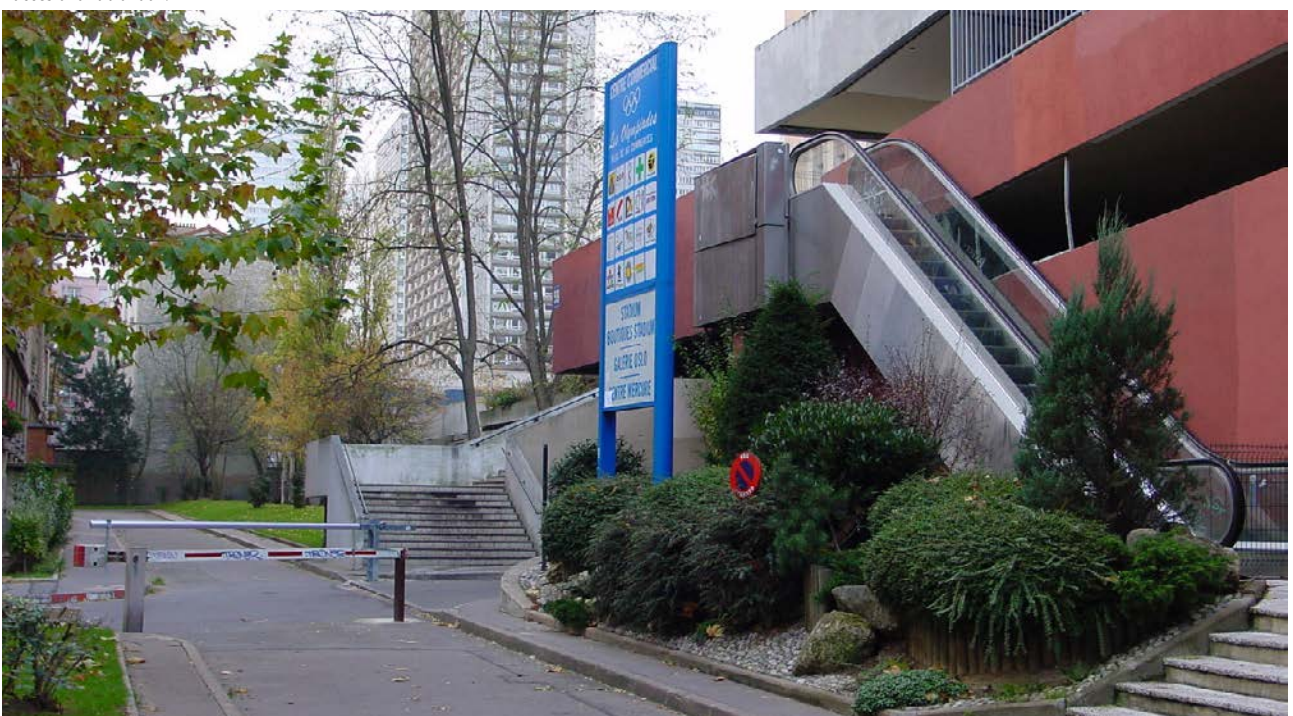
L'accès avant travaux.
