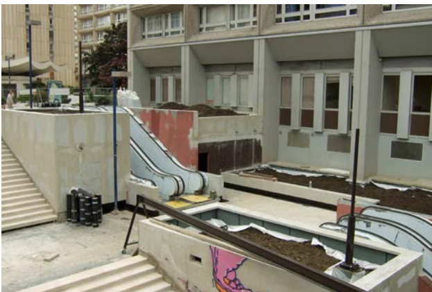
Travaux préparatoires aux plantations : mise en place des substrats, drains, géotextiles
