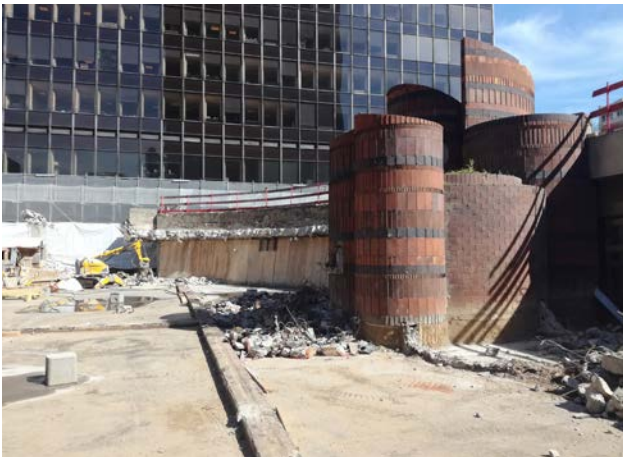
Le « jardin bas » en cours de travaux.
