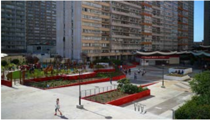
PROJET ET RÉALISATION : 2011 - 2013
