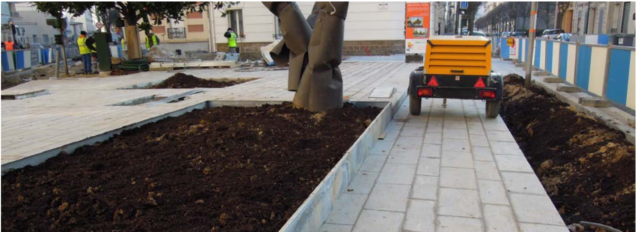
Les sols de la rue Massue à la fin des travaux, avec le réseau d'arrosage automatique qui sera recouvert par un paillage.
