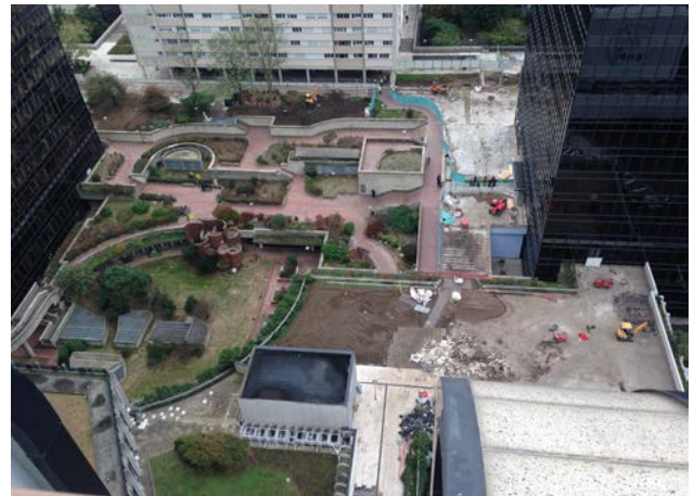
Le cœur du projet au démarrage du chantier.
