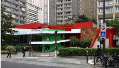
PROJET ET RÉALISATION : 2011 - 2013
