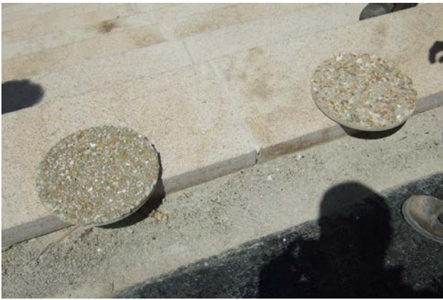
Palette de matériaux de sol : marches en granit jaune et sols courants en béton désactivé
