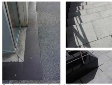
Exemples de caniveaux destinés au relevé d'étanchéité
