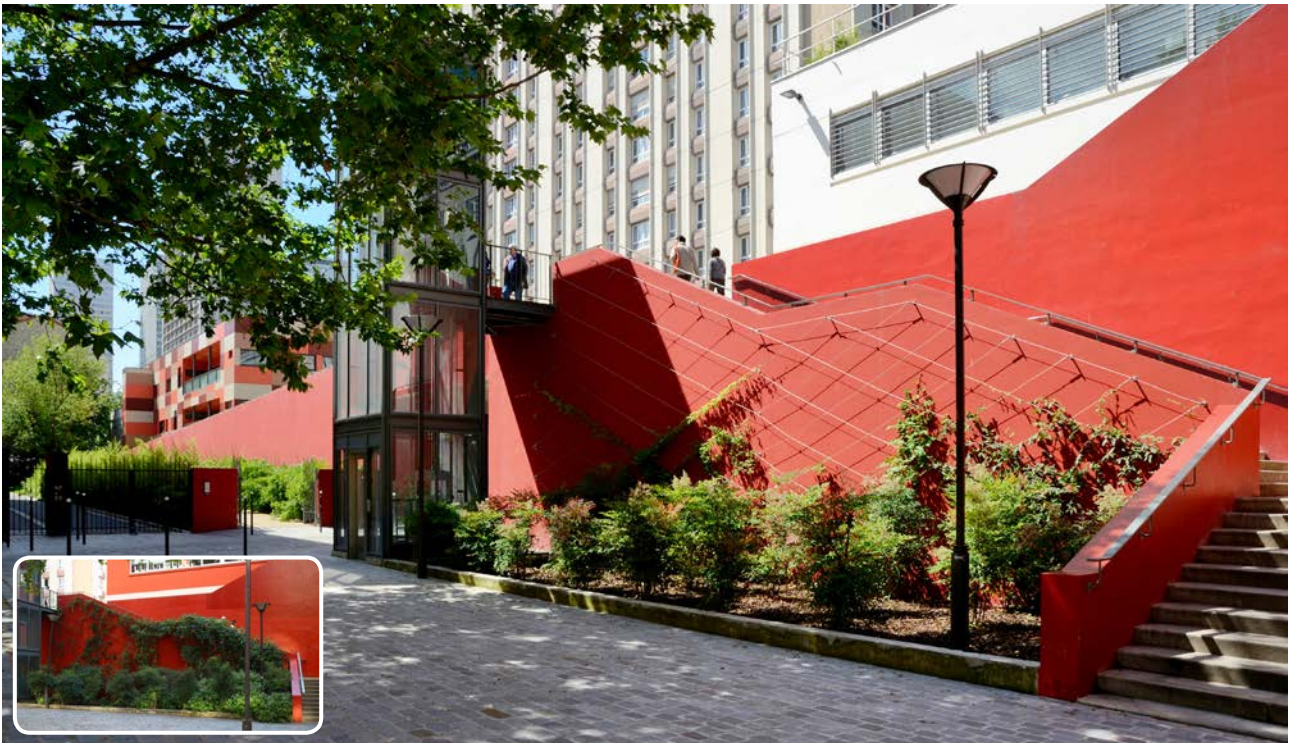
L'escalier, l'ascenseur et au loin, la rampe. Encart : les plantations 3 ans après la fin des travaux.
