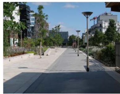
Promenade piétonne sur couverture de voies SNCF (Paris, promenade plantée Claude Lévi-Strauss)
