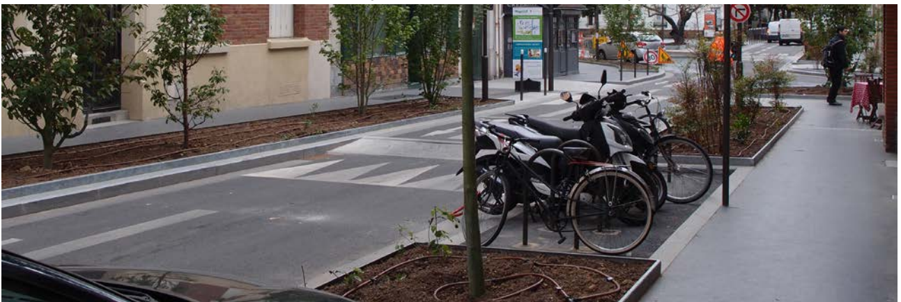
Les sols de la rue Massue à la fin des travaux, avec le réseau d'arrosage automatique qui sera recouvert par un paillage.
