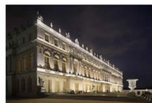
Château de Pau : mise en lumière
