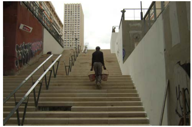
Le grand emmarchement en granit... et les difficiles conditions d'approvisionnement du chantier
