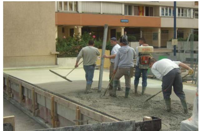
Mise en œuvre du béton désactivé (lissage et application du désactivant de prise)
