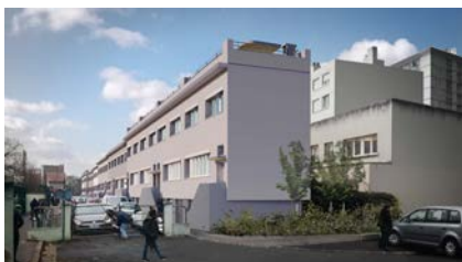
PROJET ET RÉALISATION : ? - en cours
