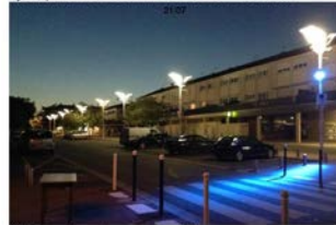
Eclairage bleu de passages piétons
