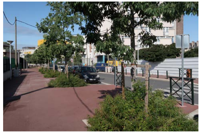
Une voie Nord-Sud aménagée. 2019
