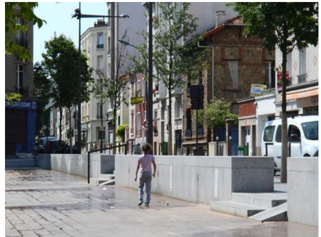
Les brumisateurs intégrés dans le mur, le caniveau et ses annexes.
